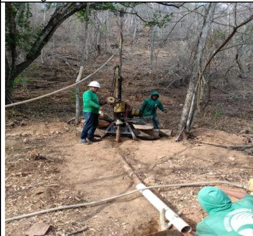
FOTO 11 – SR6-Execução do Furo da Sondagem
