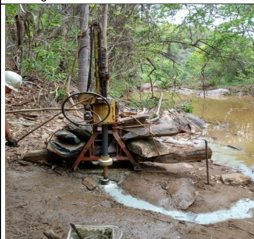
FOTO 09 – SR5 – Execução do Furo da Sondagem
