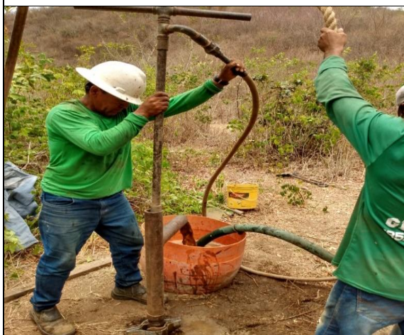
FOTO 04 – SPT 3 - EIXO 2a (9,30m)
