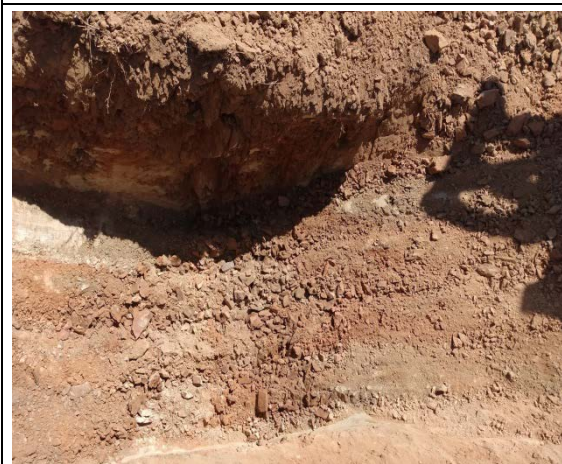
FURO 11 –. SPP-11- Filito 0,80)
