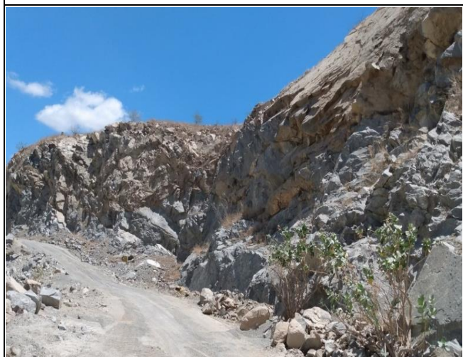
FOTO 03 –. Pedreira ativa (CLC)
