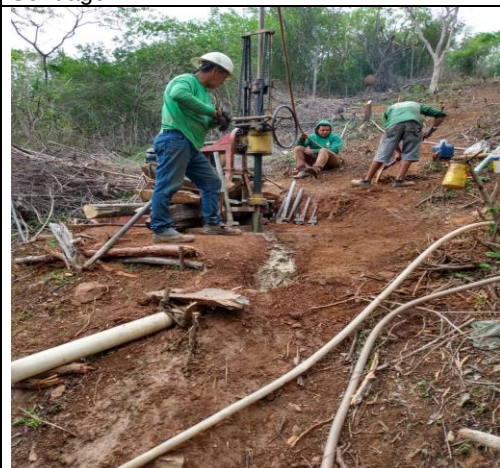
FOTO 17 –. SR9-Execução do Furo da Sondagem
