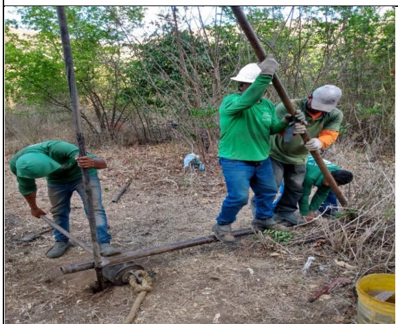
FOTO 03 – SPT 2 - EIXO 2a (6,40m)
