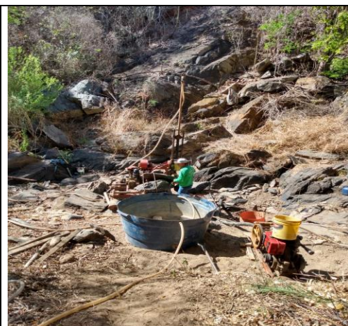
FOTO 01 –. SR1-Execução do Furo da Sondagem
