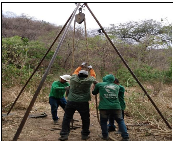
FOTO 01 – SPT 1 - EIXO 2a (4,50m)
