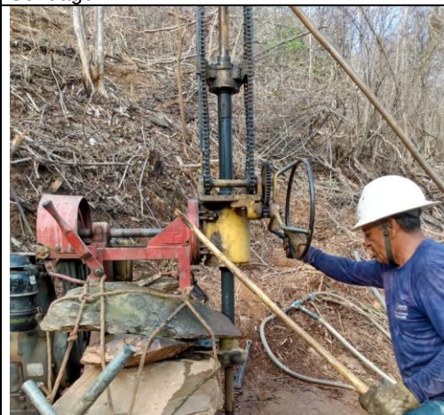
FOTO 05 –. SR3 – Execução do Furo da Sondagem
