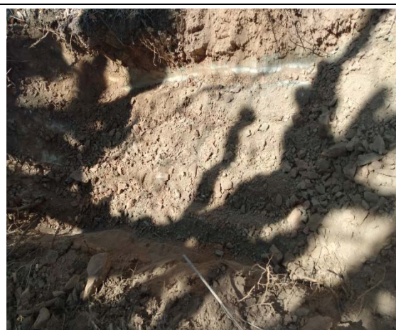
FURO 10 –. SPP-10- Filito (0,60)
