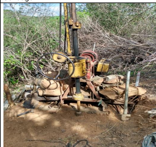
FOTO 15 –. SR8 – Execução do Furo da Sondagem
