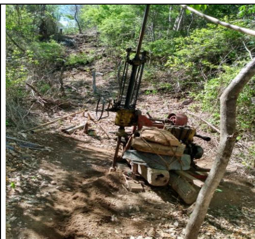
FOTO 13 –. SR7 – Execução do Furo da Sondagem
